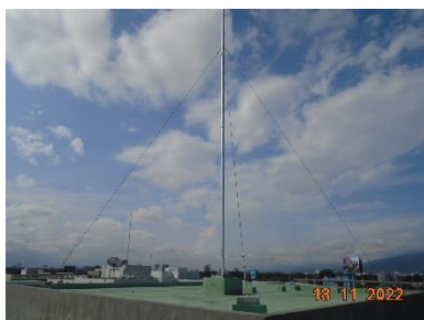
ภาพที่ 2-41 ระบบป้องกันฟ้าผ่าแบบสายล่อฟ้า
