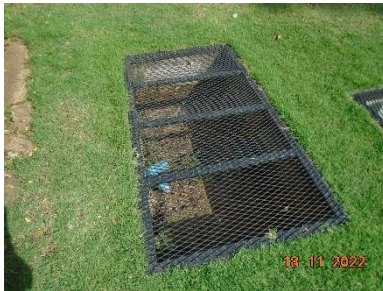
ภาพที่ 2-14 ป่อบำบัดก๊าซมีเทน
